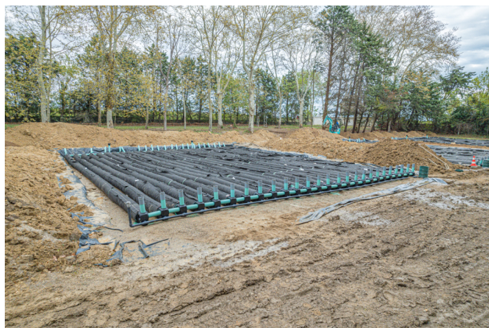
Mise en place de l'un des 3 filtres Enviro))Septic
