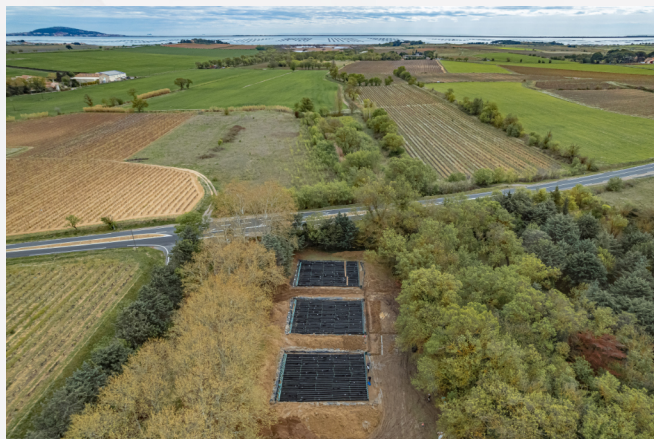
Vue aérienne sur les 3 filtres Enviro))Septic et aperçu de l'étang de Thau
