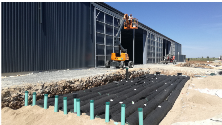
Travaux de mise en œuvre de l'EnviroSeptic
