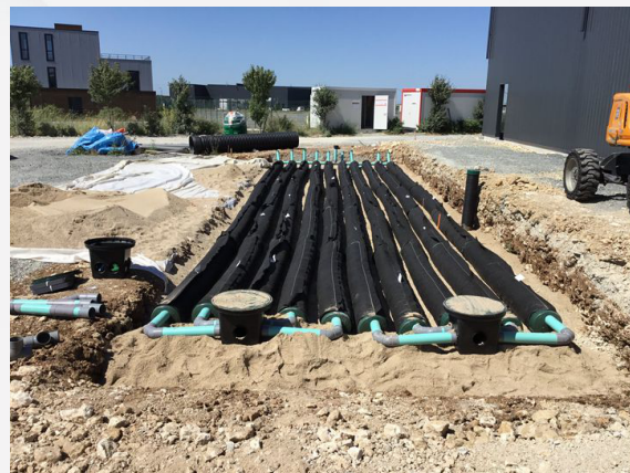
Travaux de mise en œuvre de l'Enviro))Septic
