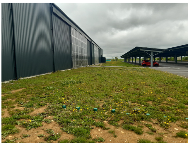
Intégration paysagère de l'EnviroSeptic
