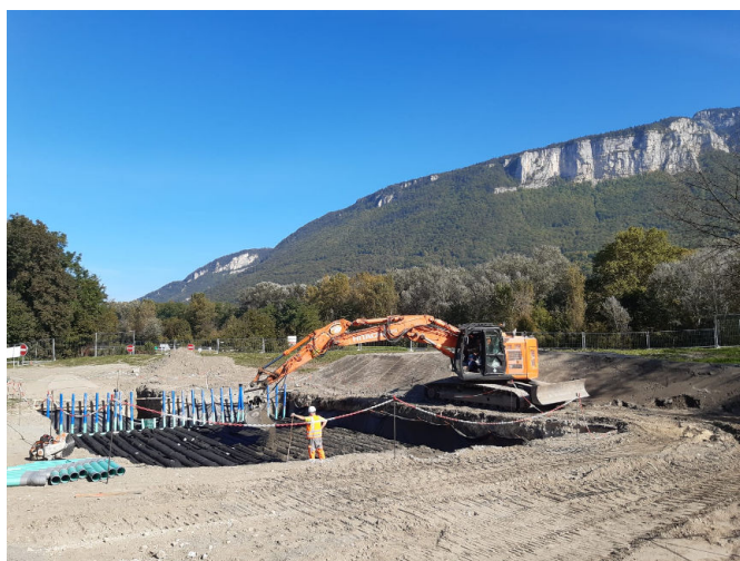
Travaux de mise en œuvre de l'EnviroSeptic - Recouvrement des conduites avec du sable
