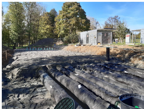
Mise en œuvre de l'EnviroSeptic - Aire de repos de l'Albenc 2022
