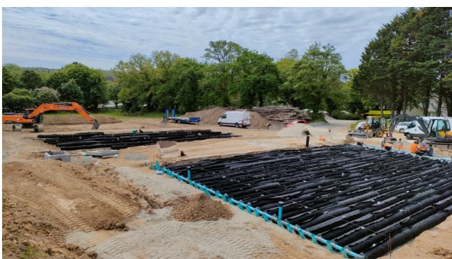
Vu d'ensemble du chantier : filtre EnviroSeptic, PITT et Saulaie
