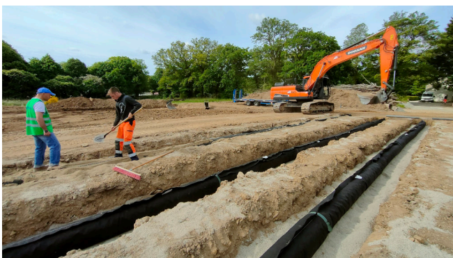
Mise en œuvre du PITT en tranchée
