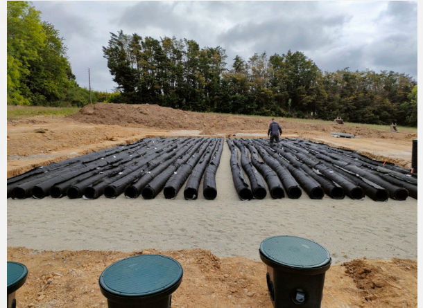
Travaux de mise en œuvre de l'EnviroSeptic - Assemblage des conduites
