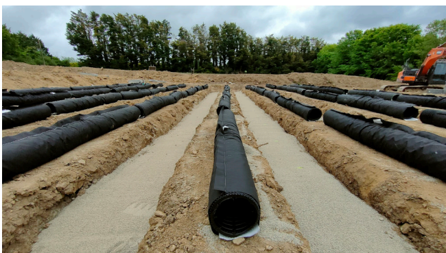
Pack d'Infiltration et de Traitement Tertiaire (PITT) prêt à être mis en œuvre
